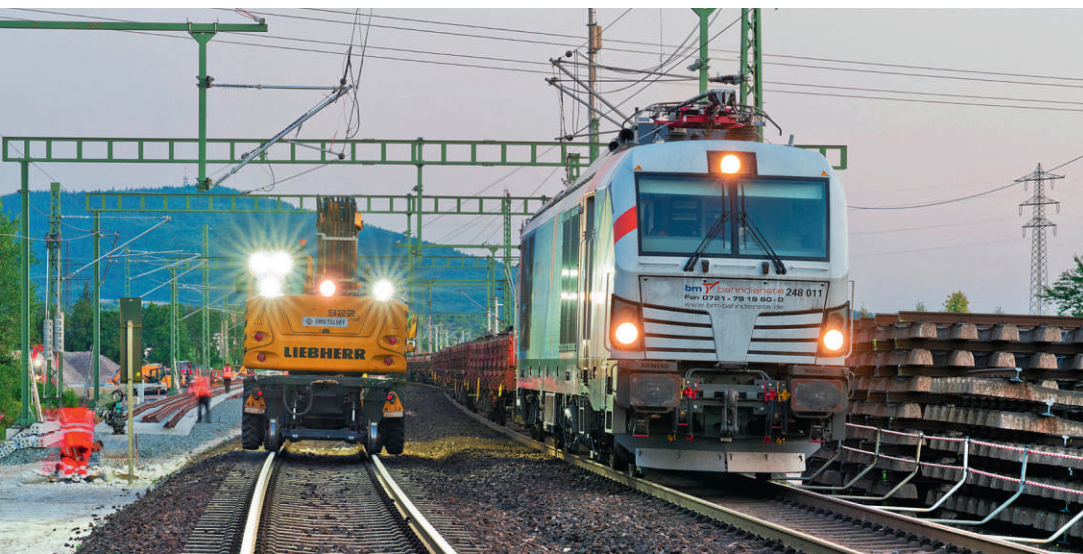
Blick auf die Baustelle in Rastatt Süd: 248 011 von BM Bahndienste war am 10.08.24 neben Zweiwegebaggern und zahlreichen Bauarbeitern im Einsatz. Foto: Rudolf Warda
