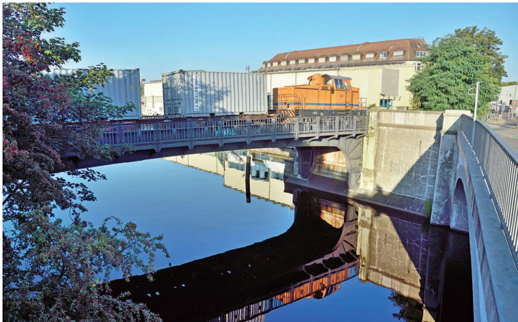
An der Lahnstraße wird auch der Neuköllner Schiffahrtskanal überquert, hier spiegelte sich am 12.08.20 Lok DL7 (ML 700C) im Wasser. Für diese Maschine war 2020 das letzte Jahr bei der IGB.
